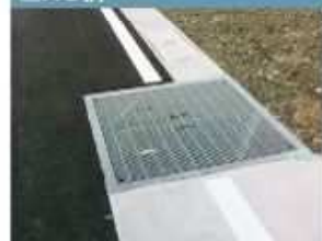
▲山梨県南アルプス市
