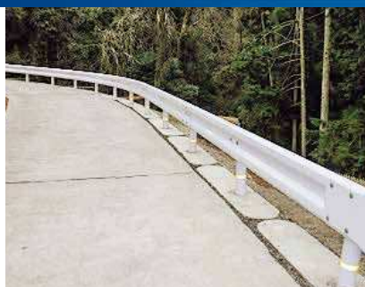
長浜土木事務所(滋賀県)
