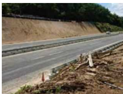
西日本豪雨災害 復旧工事にて
