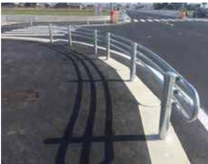
岐阜土木事務所 (岐阜県)
