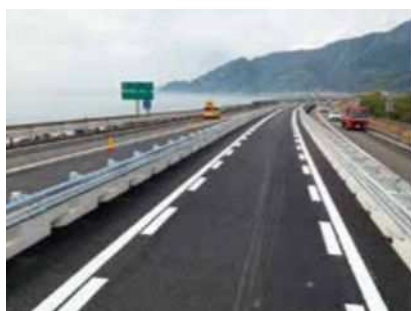
東名高速道路（特定更新等） 富士IC～清水IC間床板取替工事
