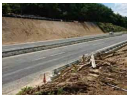
西日本豪雨災害 復旧工事にて
