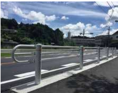
豊田加茂建設事務所 (愛知県)
