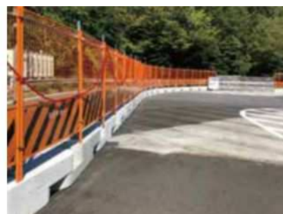
NEXCO中日本 東名高速道路 鮎沢PAランプ新設工事（A型）
