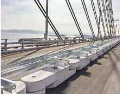
本州四国連絡高速道路(岡山県)
