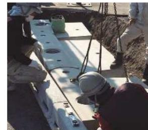
製品に設けられた凸凹を目安に、基礎同士を重ね合わせで設置していきます。
