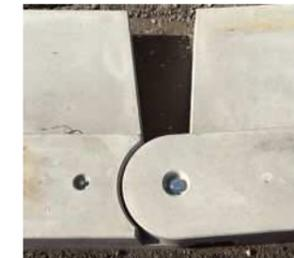
製品同士を M27 連結ボルトで連結します。ボルト連結後はモルタルを充填しボルトを保護します。
