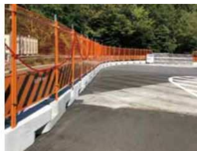
NEXCO中日本 東名高速道路 鮎沢PAランプ新設工事（A型）
