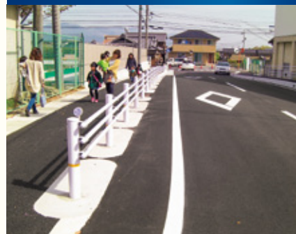
亀山市役所(三重県)
