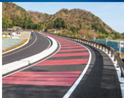
沼津河川国道事務所(静岡県)
