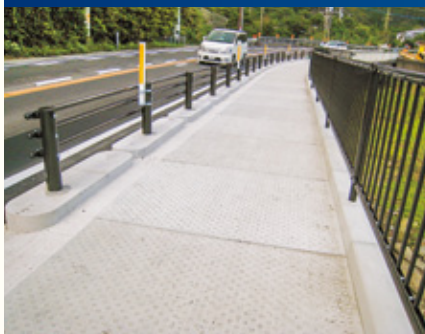
宮崎河川国道事務所(宮崎県)
