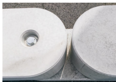
M27 ボルトを使用して連結
