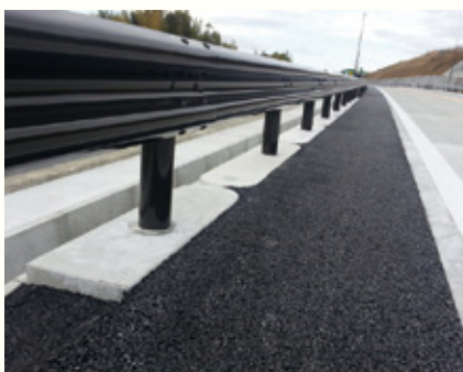
沼津河川国道事務所(静岡県)
