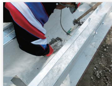
⑤ 連結部モルタル詰め
