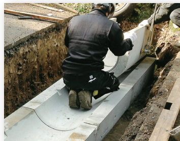
③ 側溝据え付け
