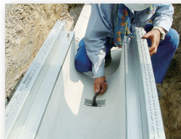
④ 固定ボルト締め
