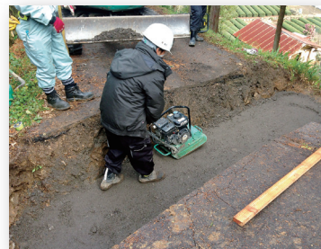
① 基礎材敷設
