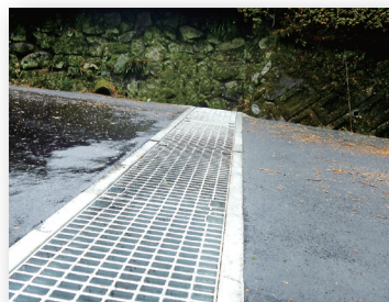
⑥ 舗装完成
