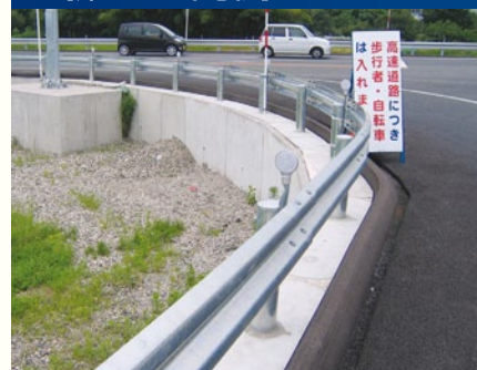
羽越河川国道事務所(新潟県)
