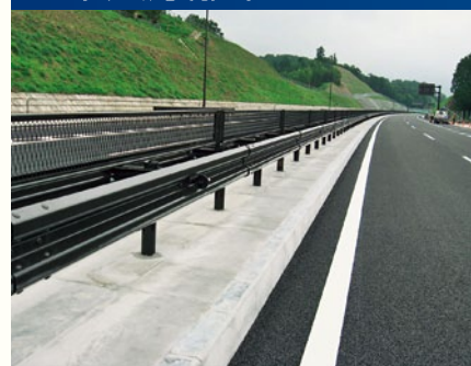
沼津河川国道事務所(静岡県)
