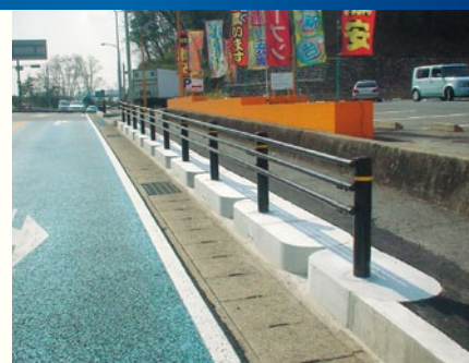
多治見砂防国道事務所(岐阜県)
