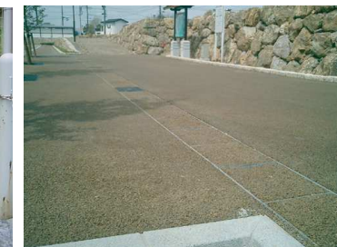
PUプレート側溝 (片面タイプ)
